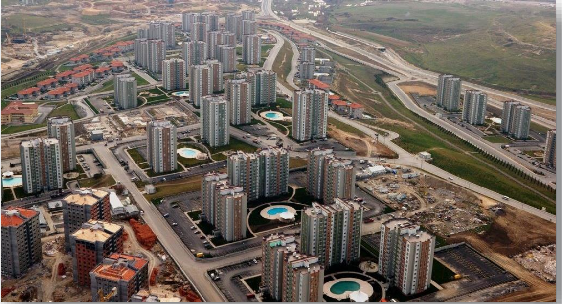
Tünel Kalıpla yapılan Soyak Olimpiakent
